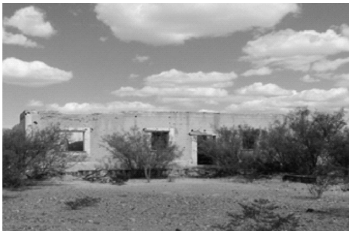
Estación de Bandera San Carlos, Coah. Km 104
